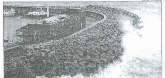
La Llotja de Llançà va quedar destrossada per les onades.
